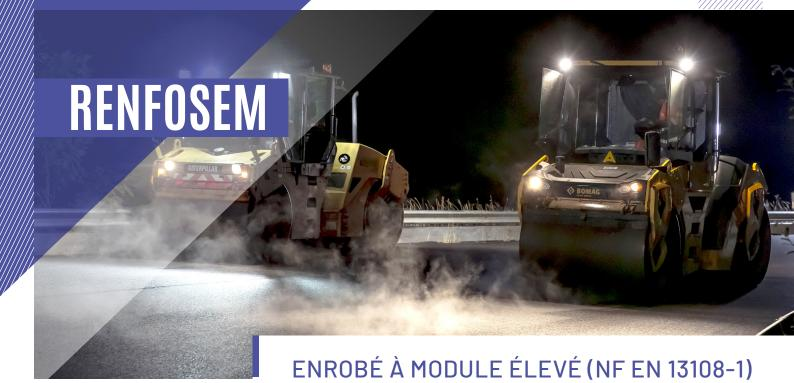
RENFOSEM est un Enrobé à Module Elevé 0/10, 0/14 ou 0/20 classe 2 de renforcement structurel pour assises de chaussées souples ou bitumineuses épaisses.
