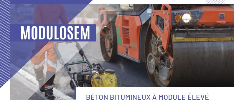
MODULOSEM est un béton bitumineux 0/10 ou 0/14 à module élevé (BBME) employant un bitume routier de faible pénétrabilité, destiné à la construction ou à l'entretien des couches de roulement des chaussées lourdement circulées.
