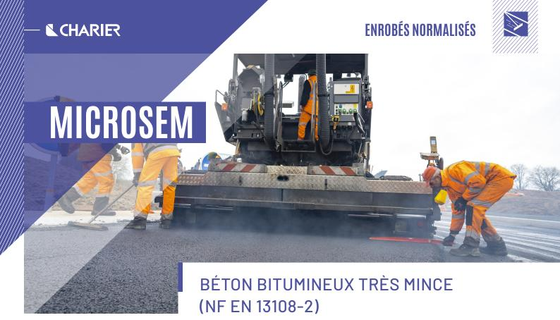
MICROSEM est un béton bitumineux très mince à chaud (BBTM 0/6) proposé pour les couches de roulement en construction neuve ou en entretien.
